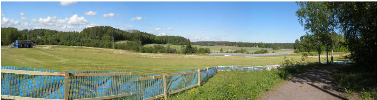
Maalisuora ja kielletyn alueen aitoja rakentamisvaiheessa
