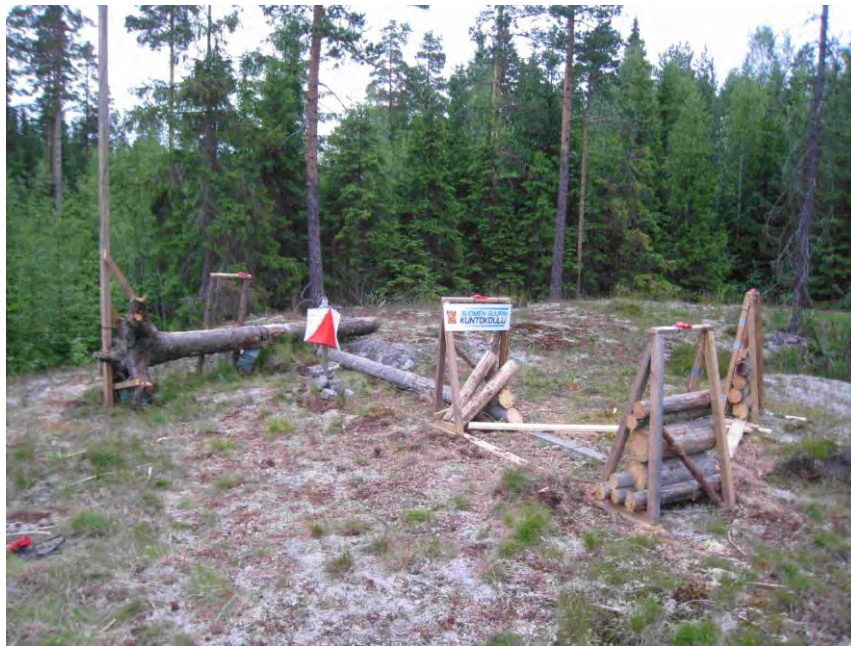
Jukolan kolmen ensimmäisen osuuden TV-rasti. Pukkien välillä puurakenteiset johtotiet kalliion pinnalla yhdistettynä pikkien kiinnitysalustaan ja kaatuneen rungon juurakkoon kiinnitetty pystytolppa ilmaakaapelia varten. Irtopukkien painoa lisäävät niihin sijoitetut pöllit. Keskimmaisessä pukissa mainostaulu.
