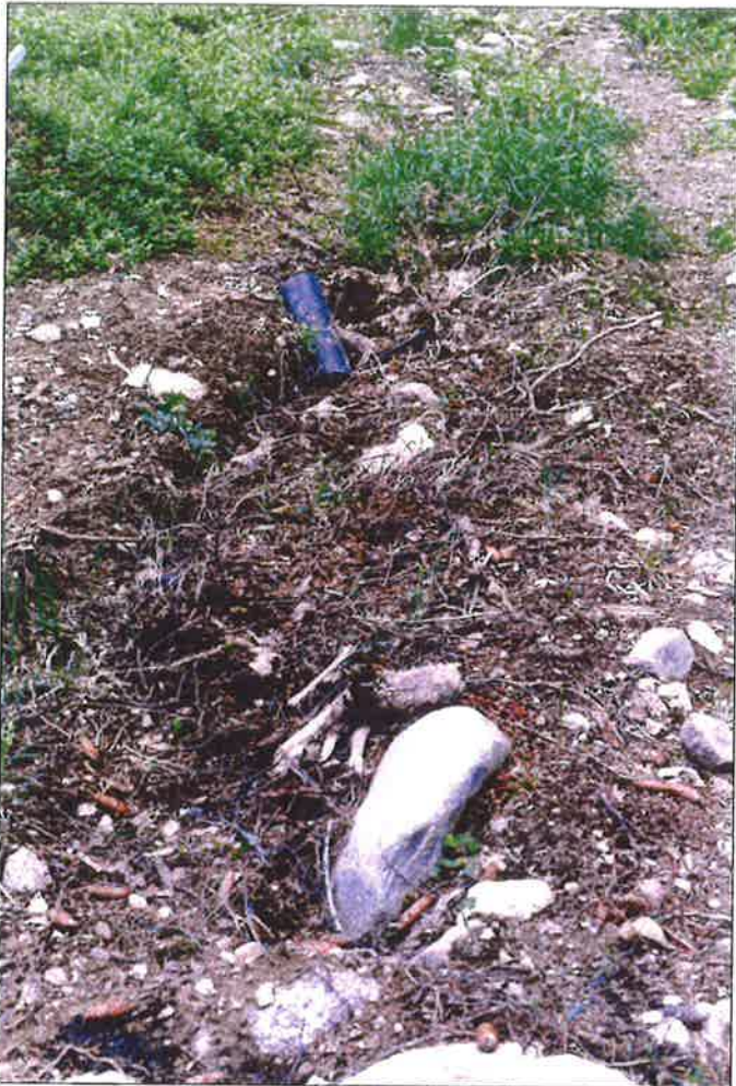
Kuva 49. Vesijohtokaivannon jälkiä metsämaastossa kesällä 1997.
