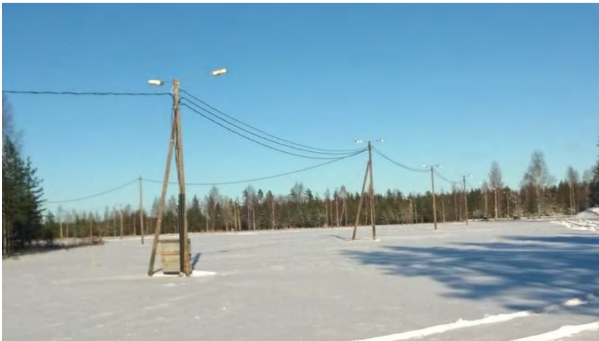
Talvehtiva Jukolan AMKA-verkko kuvattuna ravintolan jakokaappi-pylväältä pohjoiseen päin.
