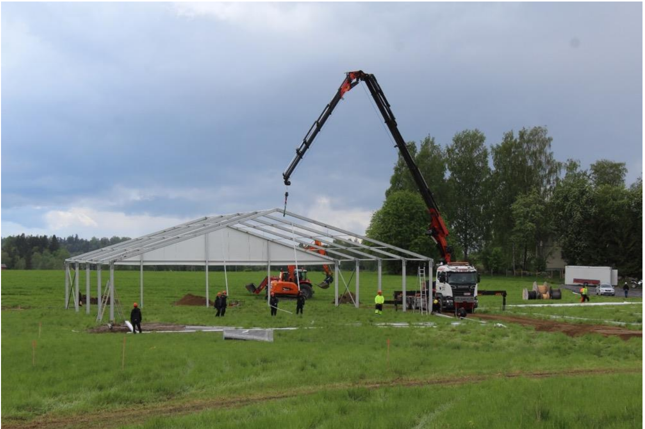
Ison kauppatehtaan rungon pystytys.
