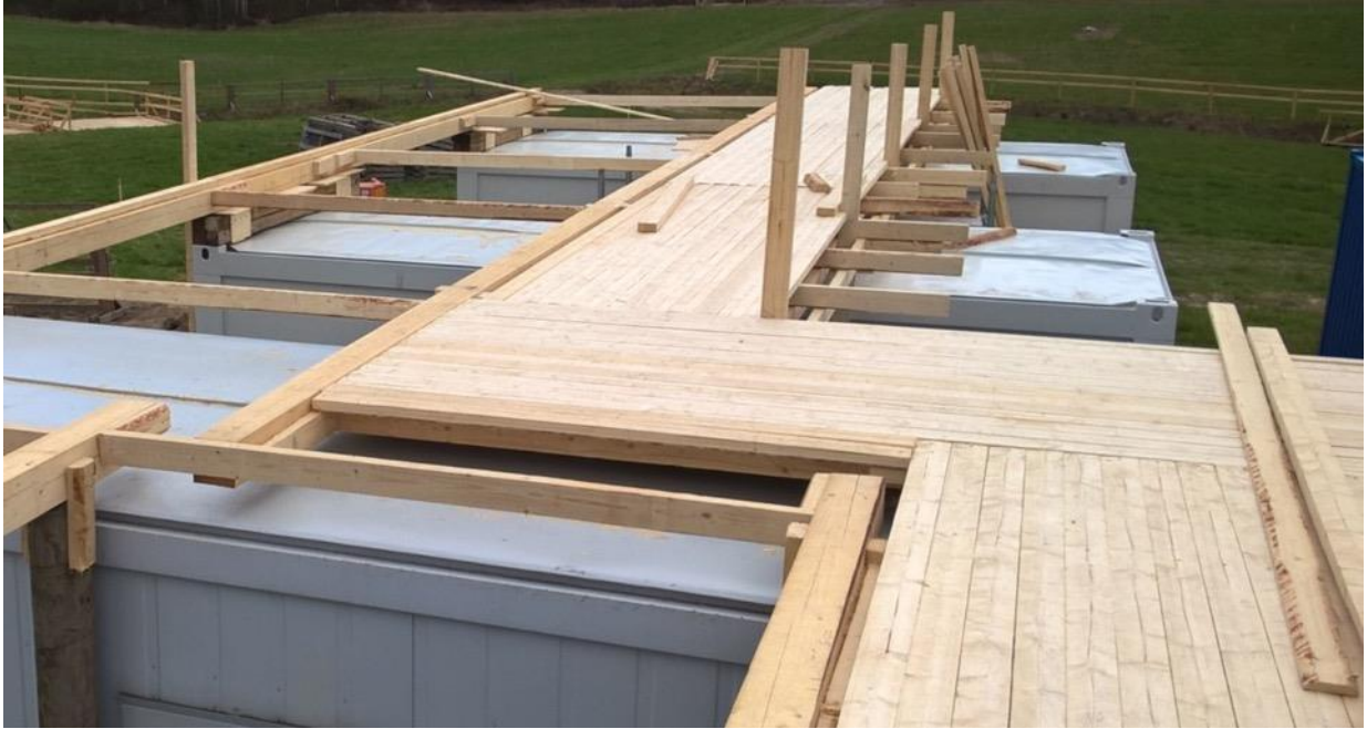
Maalialuekonttien kerrosten välirakenteet.
